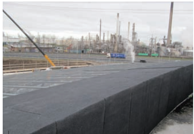
Overgang van het dak met het atrium.
