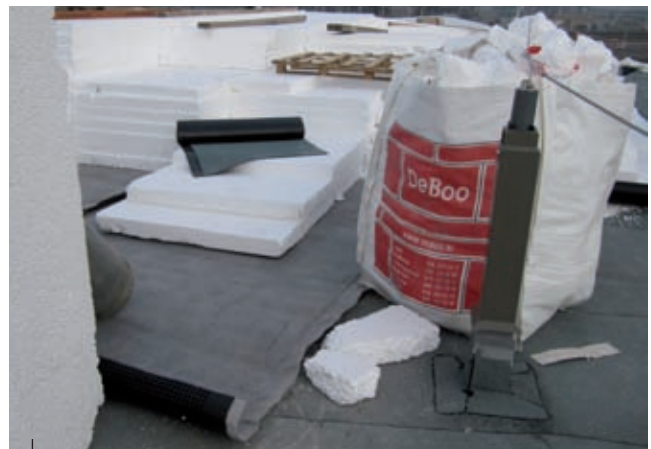
EPS-isolatie op de drainagelaag.
