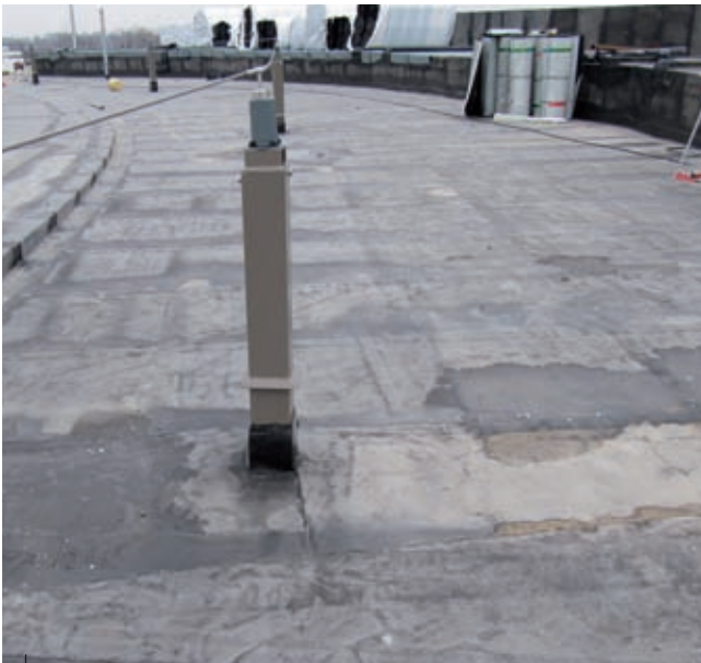
Balusters voor de valbeveiliging.
